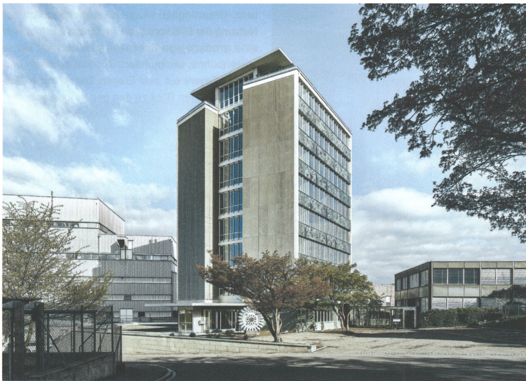
Das Hochhaus der Kabelwerke in Brugg wurde behutsam saniert.
