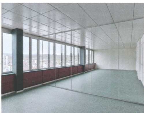
Die Architekten ersetzen die Fenster; die neuen unterscheiden sich dank schlanken Profilen nur wenig.
