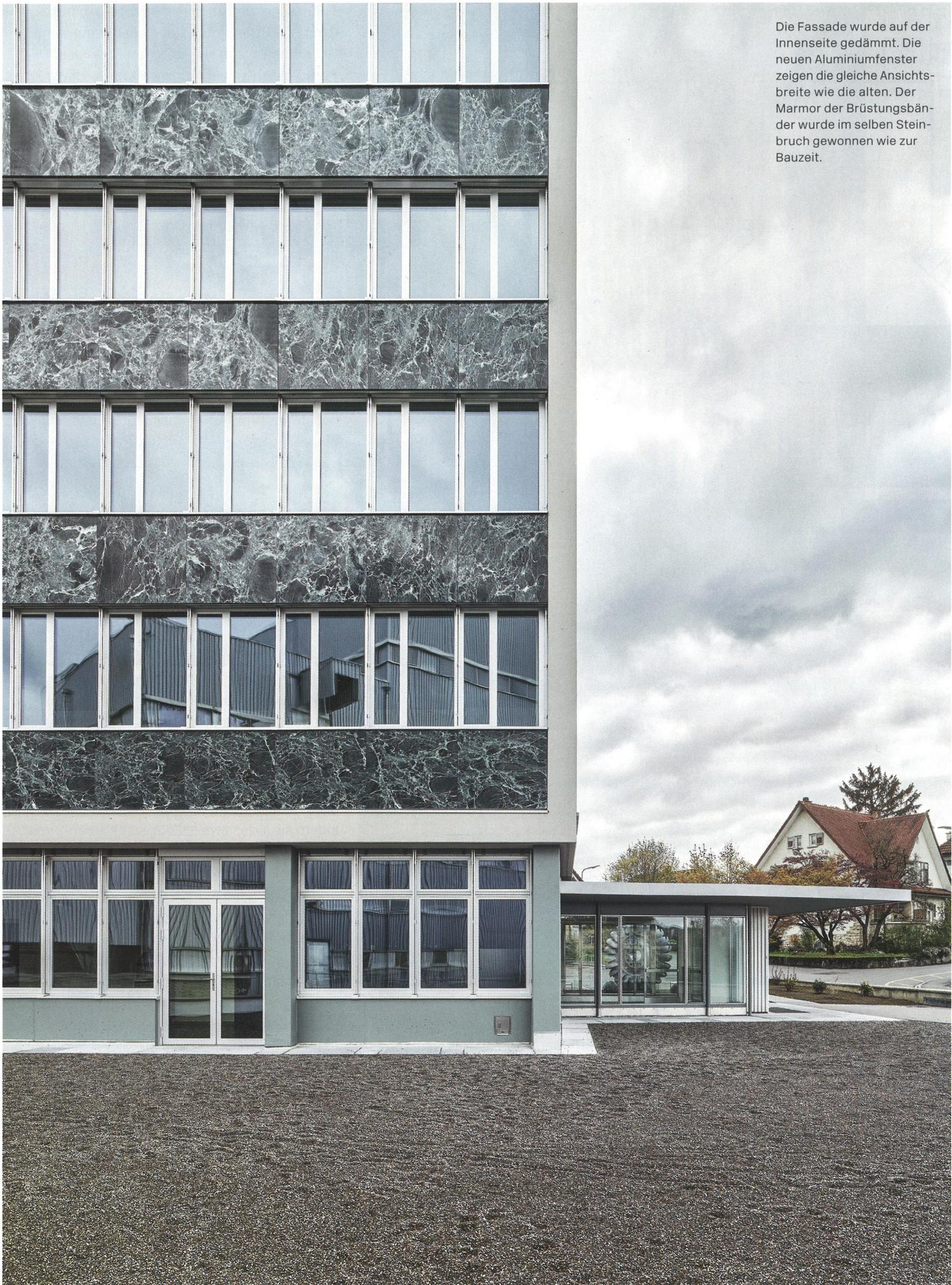
Die Fassade wurde auf der Innenseite gedämmt. Die neuen Aluminiumfenster zeigen die gleiche Ansichtsbreite wie die alten. Der Marmor der Brüstungsbänder wurde im selben Steinbruch gewonnen wie zur Bauzeit.
